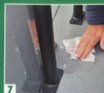
7 Une fois les inserts collés et vissés, il faut dégraisser la surface, qui va pouvoir recevoir de façon définitive les pieds. Un cordon de silicone apportera une résistance supplémentaire et, surtout, une étanchéité optimale.
