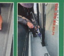
7 Une fois les inserts collés et vissés, il faut dégraisser la surface, qui va pouvoir recevoir de façon définitive les pieds. Un cordon de silicone apportera une résistance supplémentaire et, surtout, une étanchéité optimale.
