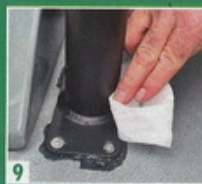
9 Le nettoyage des platines permet de retirer le surplus de silicone. La première étape – celle de la fixation des pieds – est terminée.
