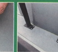
9 Le nettoyage des platines permet de retirer le surplus de silicone. La première étape – celle de la fixation des pieds – est terminée.
